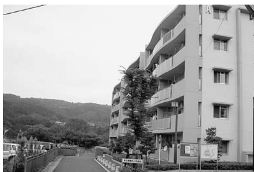
市営住宅 (井ノ尻団地)
